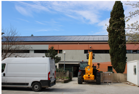
Les panneaux photovoltaïques, écologiques et économiques, sont en place.
