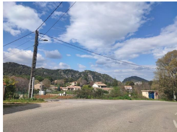
Vue depuis Chemin de Veyrac
