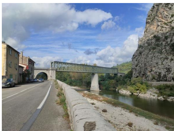
Les ouvrages d'art sur la rivière
