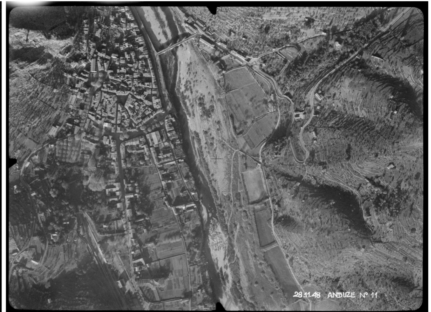
Figure 15 : photo aérienne 1948, centre ancien et du sud de la ville. La physionomie globale a été peu modifiée dans le bourg à l'exception de quelques constructions neuves dans la partie nord (source : IGN-R Monter le temps).
