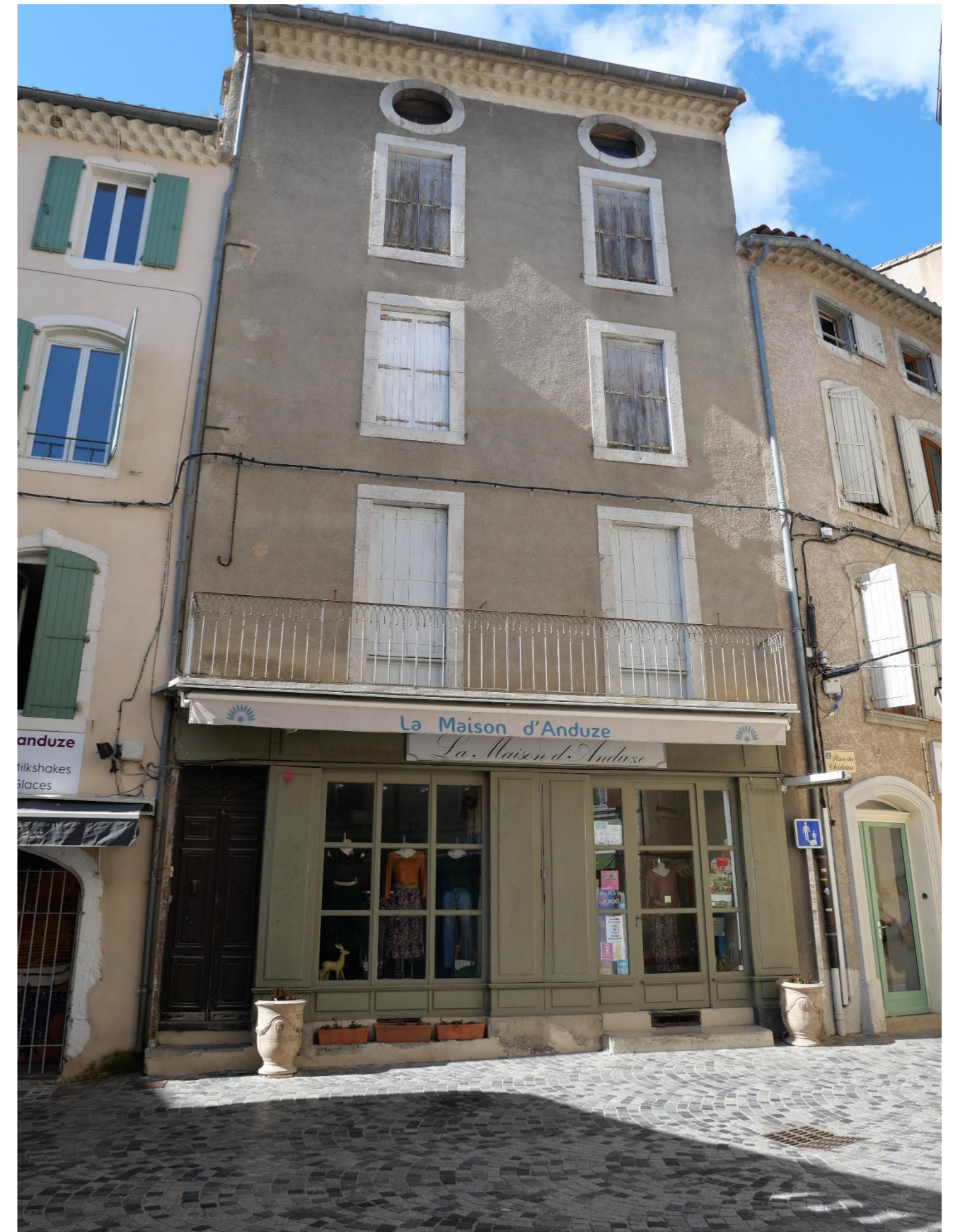
Figure 23 : place du château. Immeuble possiblement érigé au XIXe siècle qui présente une composition en travée régulière, accentuant la verticalité de cette haute façade. La devanture au rez-de-chaussée s'intègre bien, en raison notamment de la division des vitrages et de l'usage du bois peint.
