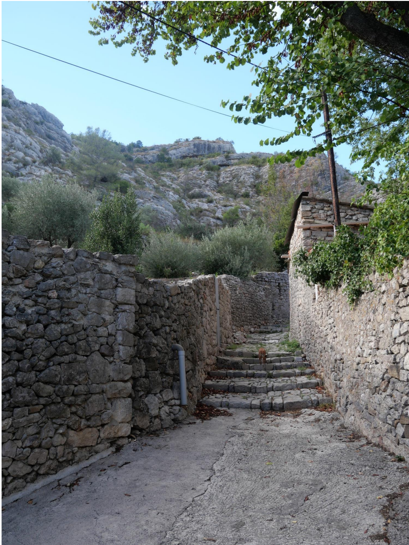
Figure 27 : calade et murs de clôture en pierre menant au chemin des prisons
