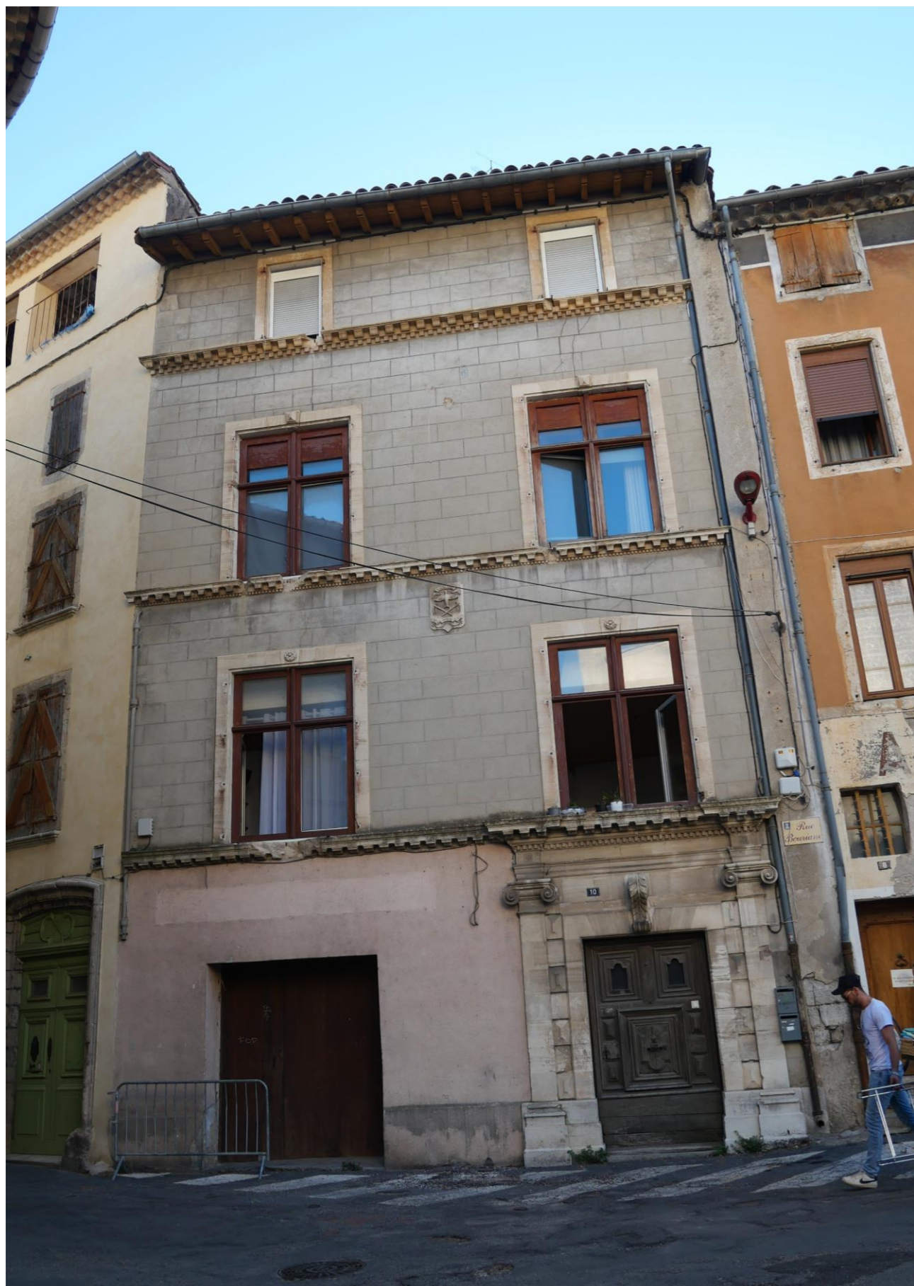
Figure 24 : rue Bouriane. Immeuble présentant des éléments en pierre de belle facture : encadrement de la porte d'entrée à pilastre et entablement, bandeaux saillants reprenant un motif de frise à denticules.
