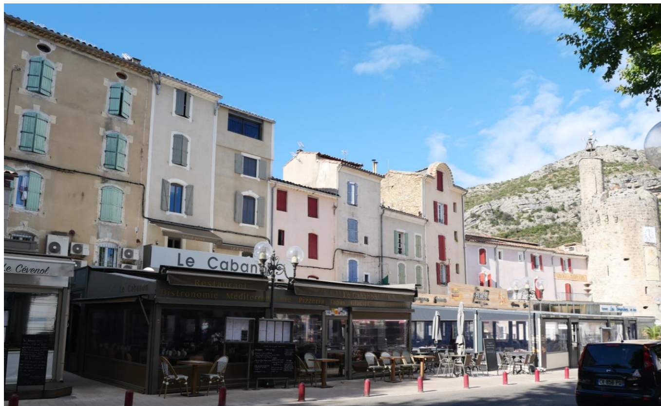
Figure 22 : le plan de Brie. Les immeubles implantés à l'emplacement de l'ancien rempart présente une grande qualité architecturale, mais l'ensemble de la place est dénaturé par les vérandas construites de manière désordonnée, qui phagocytent l'espace public et perturbent la lecture des façades.
