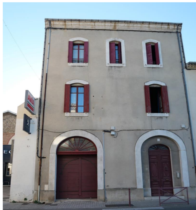
Figure 32 : immeuble relativement bien préservé de l'avenue Rollin
