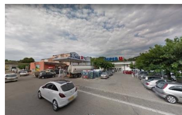
Centre commercial au Luxembourg
