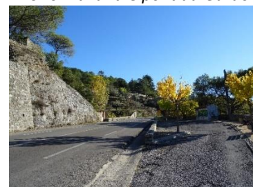
RD 910 A avant le pont du Gardon
