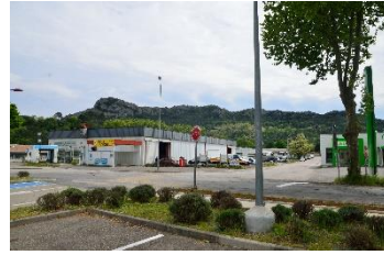
Zone d'activités – route de St Jean du Gard
