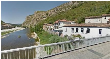
Vue depuis le pont de la route d'Alès
