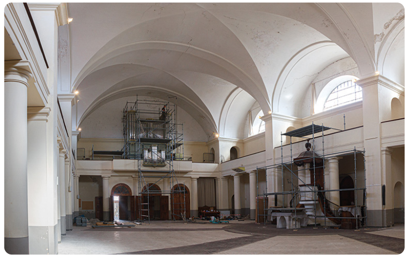
Travaux dans le Grand Temple - Installation des coffres de protection de l'orgue et de la chaire
