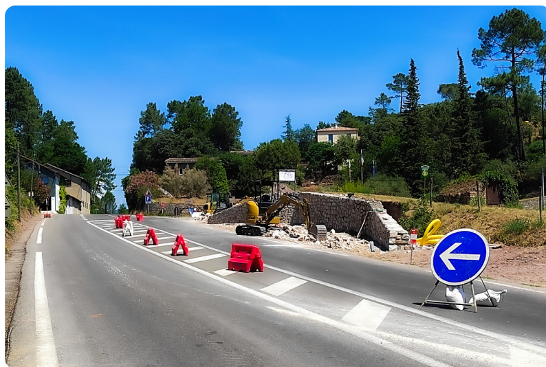
Travaux d'aménagement du carrefour RD907/chemin de Récoulin
